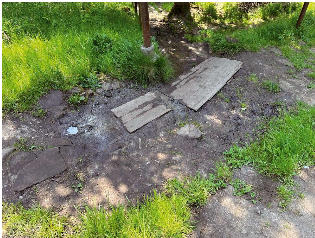
Podmáčená přístupová cesta do Divoké soutěsky u „Pohody“ je i přes opakované výzvy k opravě ve skutečně nepřijatelném stavu.
