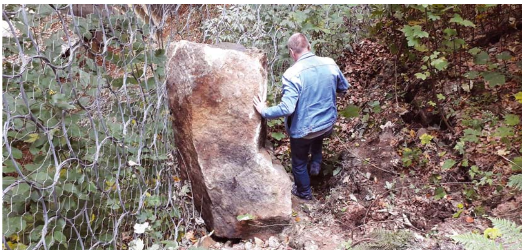
Vysokozátěžová bariéra zachytila poprvé za dobu existence ochranných bariér řícení většího rozsahu. Dosud se v případech zachytů jednalo spíše o drobné kameny nebo větve či kmeny stromů.
