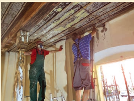
Broušení a oprava kůru v jeho dolní části
