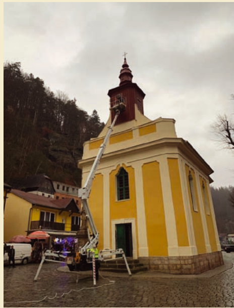
Vyzvednutí zvonů do zvonice
