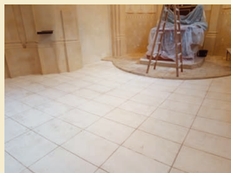
Oprava kostelní dlažby
