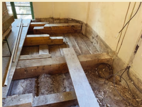
Oprava nosných prvků kůru
