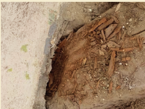
Oprava nosných prvků kůru
