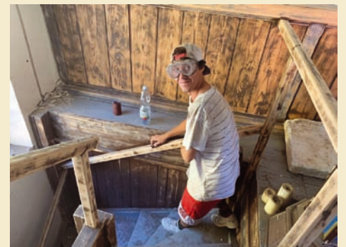
Broušení zábradlí a kůru v jeho horní části
