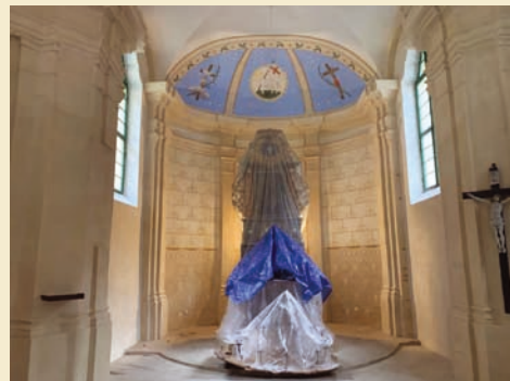
Příprava na instalaci vnitřního osvětlení
