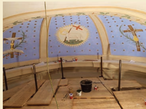
Rekonstrukce výmalby je ukončena
