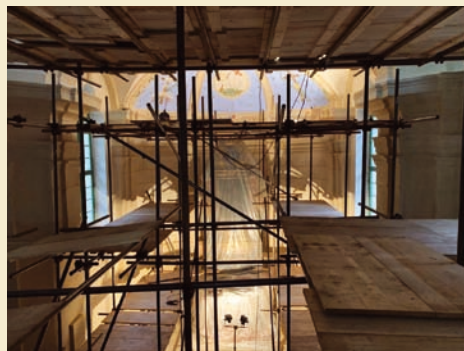
Instalace lešení pro výmalbu kostela
